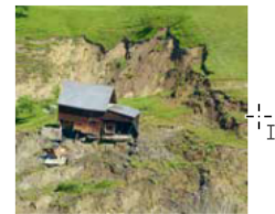
Altstätten, Ober Weidist, Rutschereignis 2013 Bei tiefgründigen Rutschungen ist ein Objektschutz kaum möglich – für Bauten ist ein anderer Standort zu suchen
