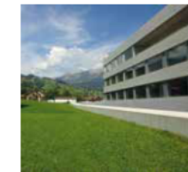
Grabs, Schutzmauer Spital Murgang Studnerbach
