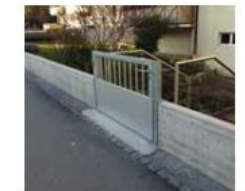
Altstätten, Arealschutz Abschirmung mit Mauer und Tor
