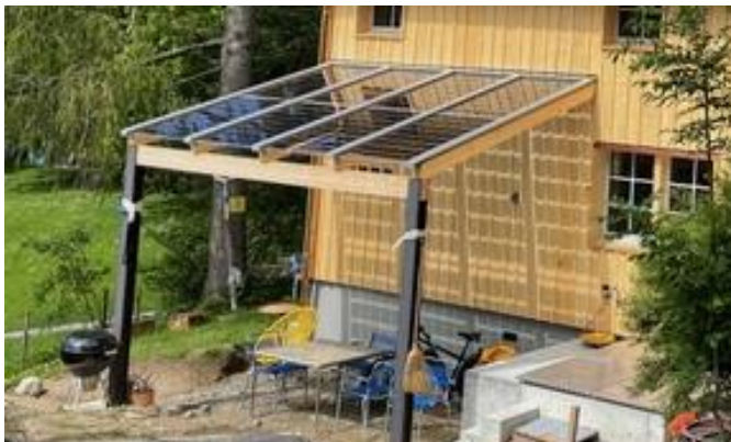
Sitzplatzüberdachung Ansicht von Garten. Foto: 2024, Niklaus Bucher
