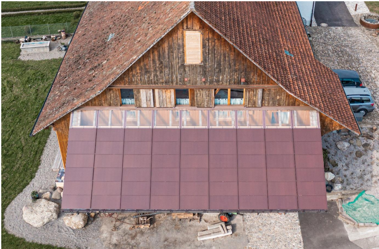
PV-Anlage auf giebelseitigem Pultdach, dadurch bleibt das Hauptdach frei. Querrechteckige Module in Farbe Terrakotta nehmen die Struktur und Farbigkeit vom Ziegeldach auf. Foto: Sunage SA
