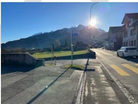
Abbildung 2: Ansicht Bushaltestelle Schulhaus Höfli
