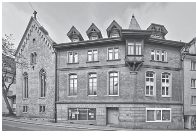
Gebäude Katharinengasse 21, St.Gallen Foto: zVg Kantonale Denkmalpflege
